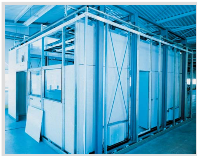
VARIOP-статика: конструкция «комната в комнате»
